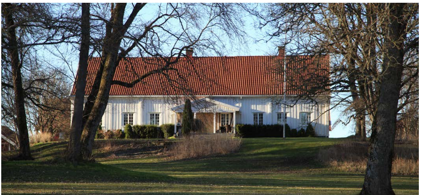
Rakkestad prestegård ble vedtaksfredet som kulturminne i 1991. Fredningen omfatter følgende bygninger: hovedbygningen, stabburet, driftsbygningens eksteriør, vognskjulets eksteriør og vedskjulets eksteriør. Foto: LOK.
